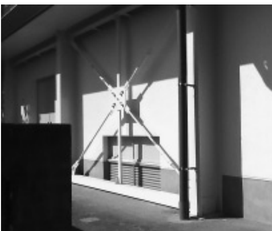
耐震工事をした体育館
